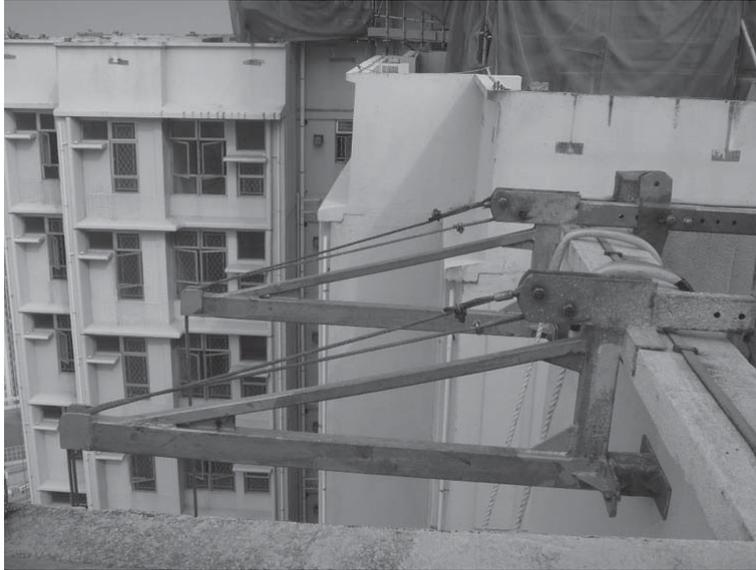
臨時吊船安裝後，在開始操作前將由一名合資格檢驗員檢查。若檢查結果合格，該合資格檢驗員將向承租人簽發證明。
